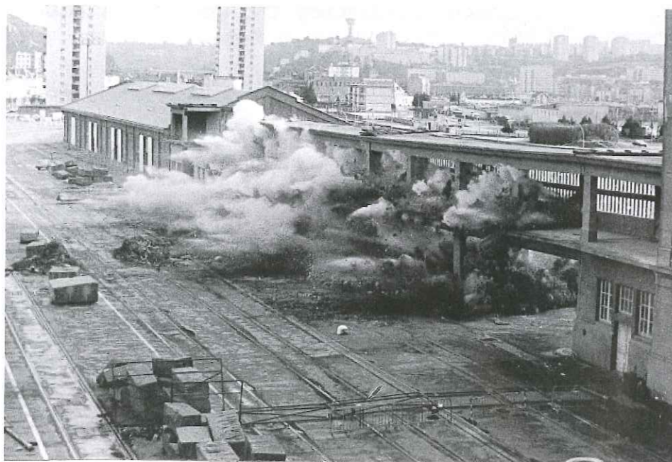
Dans les années 70-80, on fait sauter ce qu'il reste de la galerie de prolongement et une partie de l'édifice reconstruit en 1952. L'objectif consiste à libérer les terres-pleins. Au fond on aperçoit les tours du Casino et le château d'eau des Provinces. photo JM Lézec
