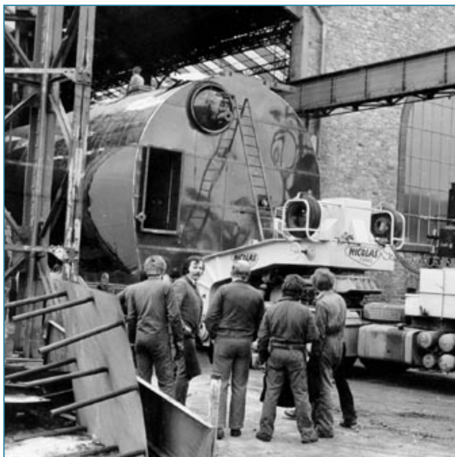
Un semi-remorque livre à l'Arsenal une puissante chaudière à vapeur construite par les Ets Lardet-Babcock. Il a fallu raccourcir un mur et réhausser la porte pour faire sortir le convoi des ateliers de la rue Guiffard à Cherbourg.
