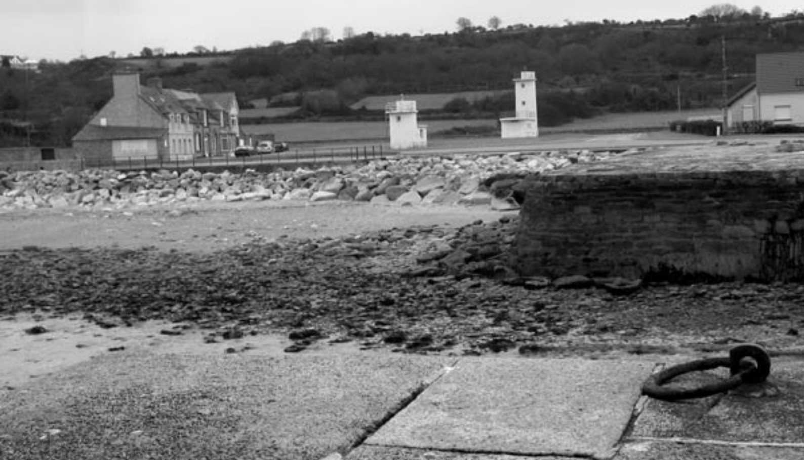
Vue depuis la digue nord, on aperçoit au premier plan le feu blanc, et au fond le feu rouge tels qu'ils ont été réalisés en 1950.
