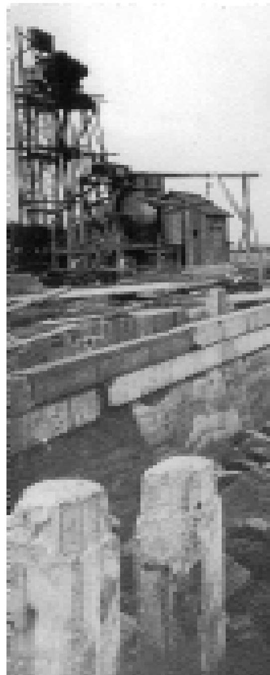
la construction du quai de France : pieux et enrochements
