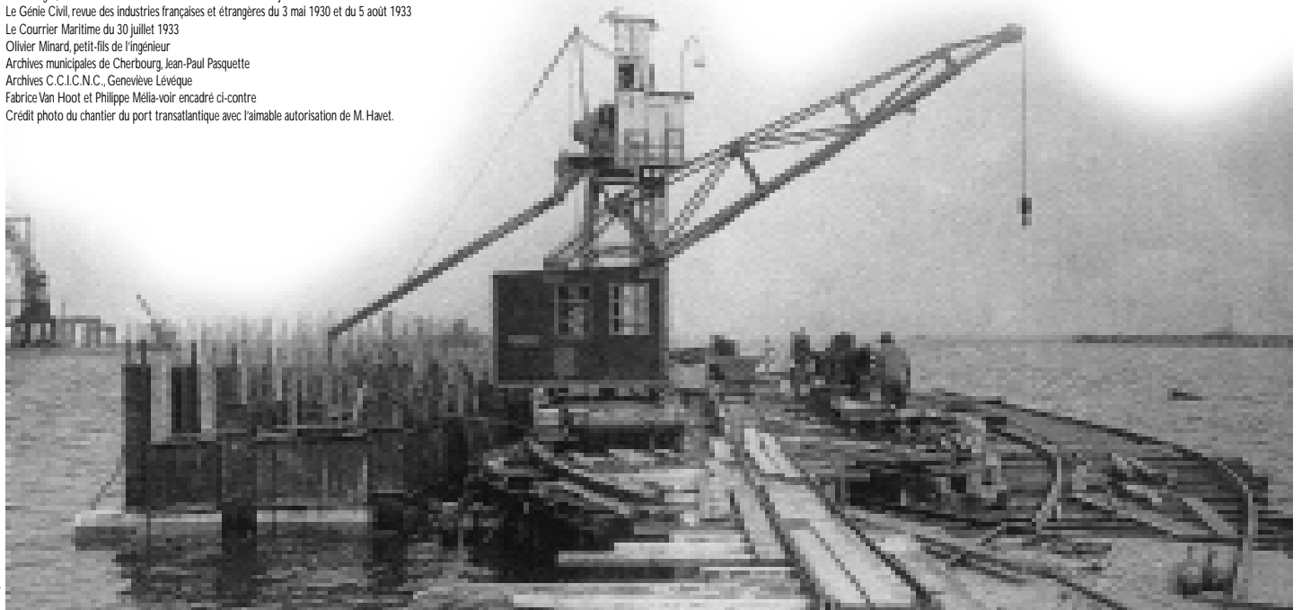
Pose du premier caisson du quai de Normandie. Ce quai est prévu pour le débarquement des marchandises, le quai de France pour l'accostage des bateaux de très fort tirant d'eau, environ 13 à 14 mètres.
