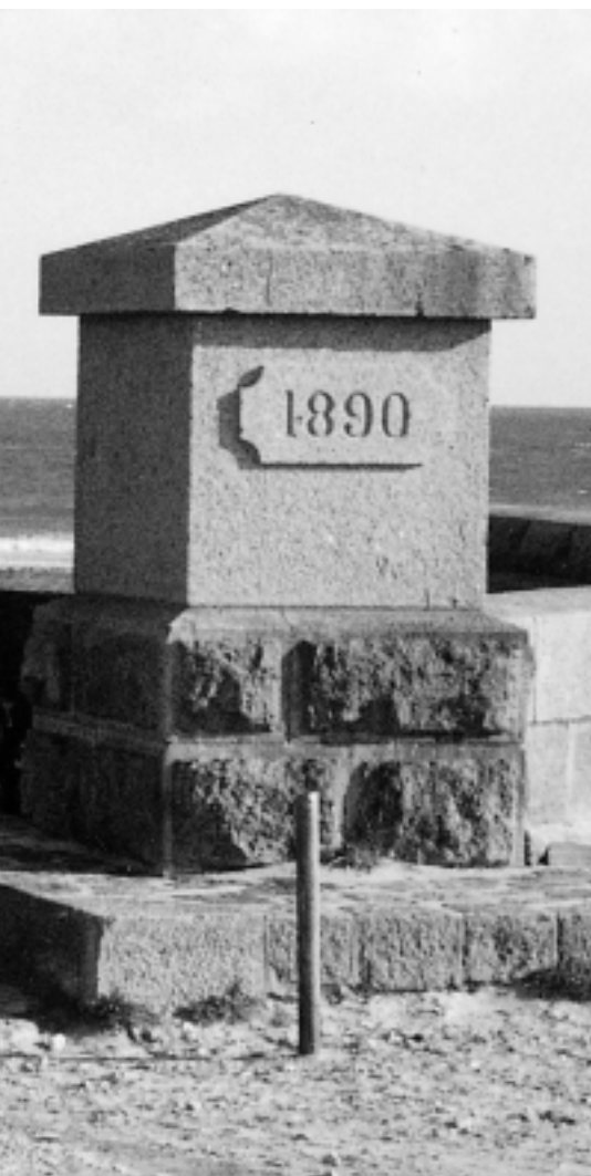
pose de la première pierre
