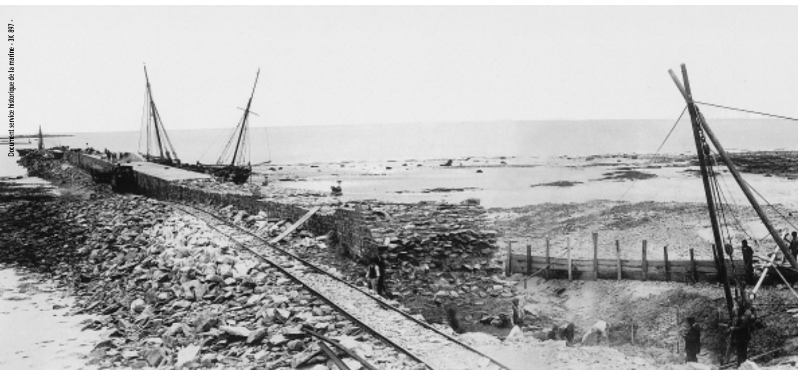
La construction de la digue de l'Est dite aussi de Collignon. Pour les besoins du chantier une ligne de chemin de fer amenait les rochers
