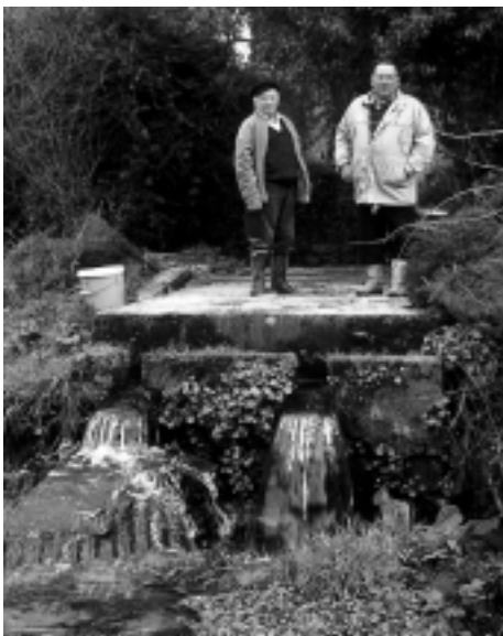
Claude Garçon et Lucien Renard posent sur le filtre à coke des cressonnières. L'eau y débouche directement de la terre et passe par ce filtre qui contient une tonne de charbon. Elle y décante et part ensuite dans les tranchées où pousse le cresson.
