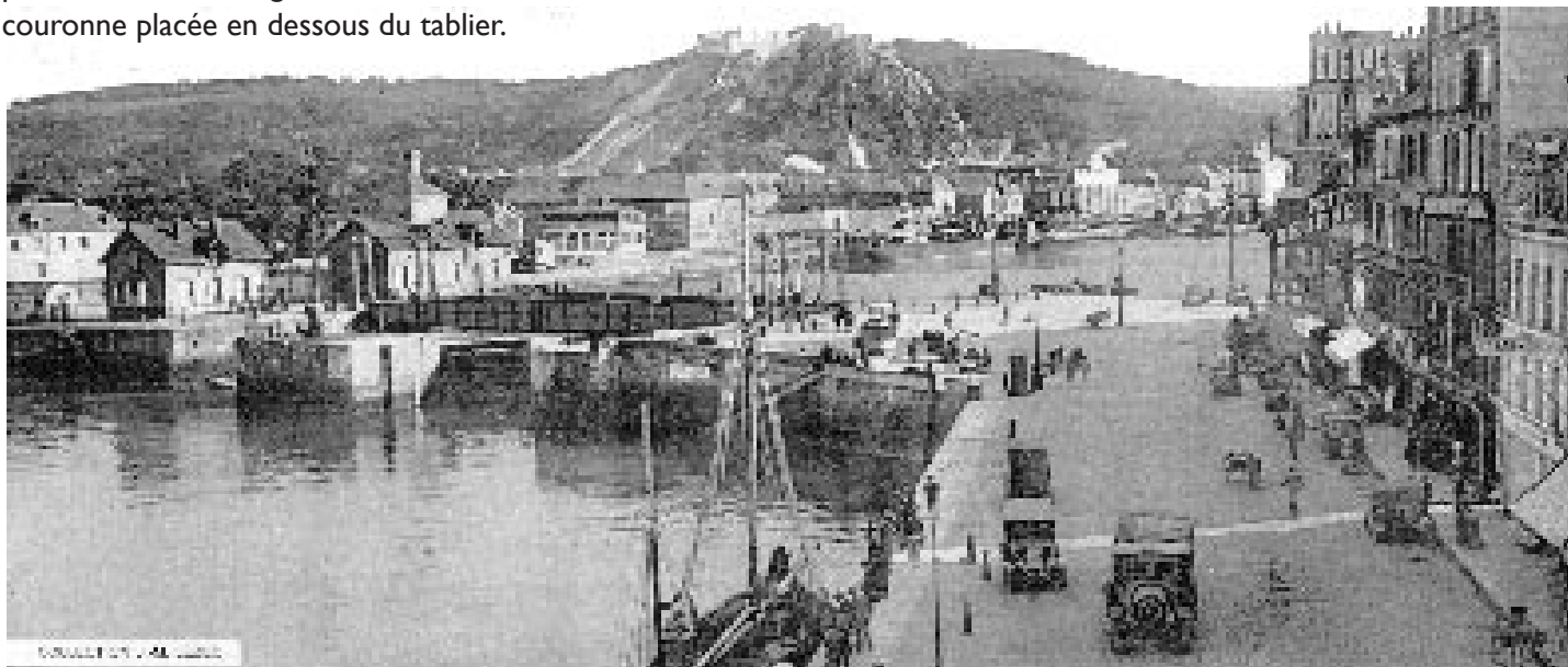
Le premier pont tournant métallique photographié dans les années 1920. On distingue les deux écluses dont l'une a été remblayée en 1958 et les caténaires du tramway électrique. Photo : Cliché X, reproduction prêtée par Jean-Marie Lézec
