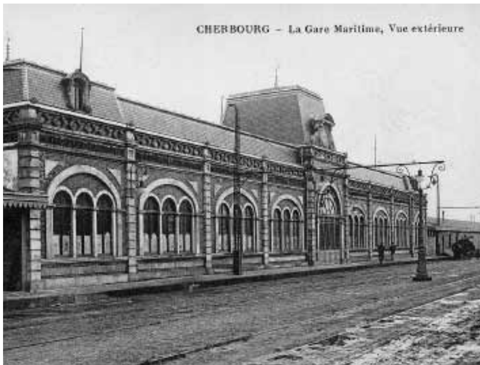
La première gare transatlantique de Cherbourg (1912-1931) quai de L'Ancien Arsenal. Elle sera très vite remplacée par celle qui est aujourd'hui la Cité de la Mer (voir Reflets n°57 ou sur www.mairie.tourlaville.fr )
