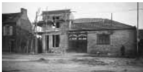
L'atelier Coupé, aujourd'hui Heleine, en construction.
